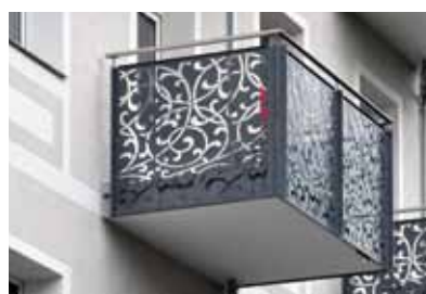
oben und links: Neubau und nachträglicher Anbau von Balkonen.
