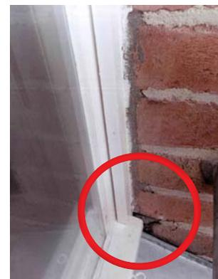
Die Verblechung an der Außenlaibung ist nicht fachgerecht geschlossen. Dadurch dringt Wasser in die Öffnung und kann nicht verdunsten. Es wird nicht nur das Fenster, sondern auch das Außenmauerwerk beschädigt.
