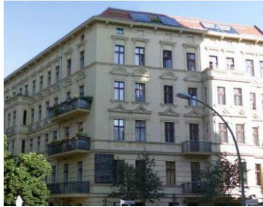
**Unten:** Die Dachaufbauten berücksichtigen weitgehend die bauzeitlichen Größenverhältnisse von historischen Dachgauben. Durch verglaste Gaubengewangen wird eine zusätzliche Verringerung einer massiven Außenwirkung erreicht.
