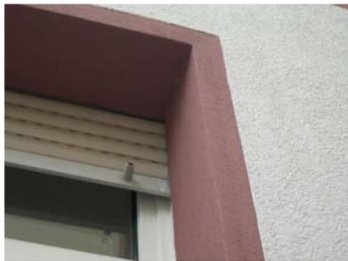
der Putzfläche die Laibungstiefe im Bereich der Fenster vermindert. Dünnere Dämmdicken verschlechtern den Wärmeschutz, verbessern jedoch die Erhaltung des Gebäudecharakters. Nur durch verbesserte, innovative und dünnere Dämmstoffe sind die Anforderungen zur Erhaltung der Baugestalt sowie eines zeitgemäßen Wärmedämmstandards zu verbinden. Bei Baudenkmälern muss die Genehmigungsfähigkeit einer Wärmedämmung im Einzelfall geprüft werden.
